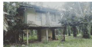
บ้านพักภารโรง ปีที่สร้าง 2537
