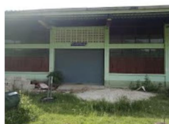
อาคารเรียนเบ็ดเสร็จ ค ปีที่สร้าง 2537
