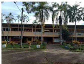
อาคารเรียนเบ็ดเสร็จ ก ปีที่สร้าง 2535
