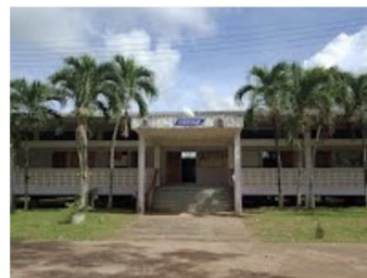
อาคารเรียนเบ็ดเสร็จ ข ปีที่สร้าง 2536
