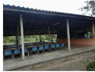
อาคารอเนกประสงค์ โรงอาหาร ปีที่สร้าง 2548 (สร้างเอง)
